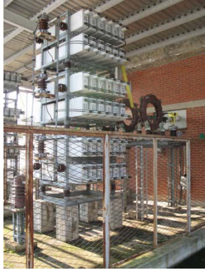
Kondenzatorska baterija, 10 kV, 3x16 Mvar
