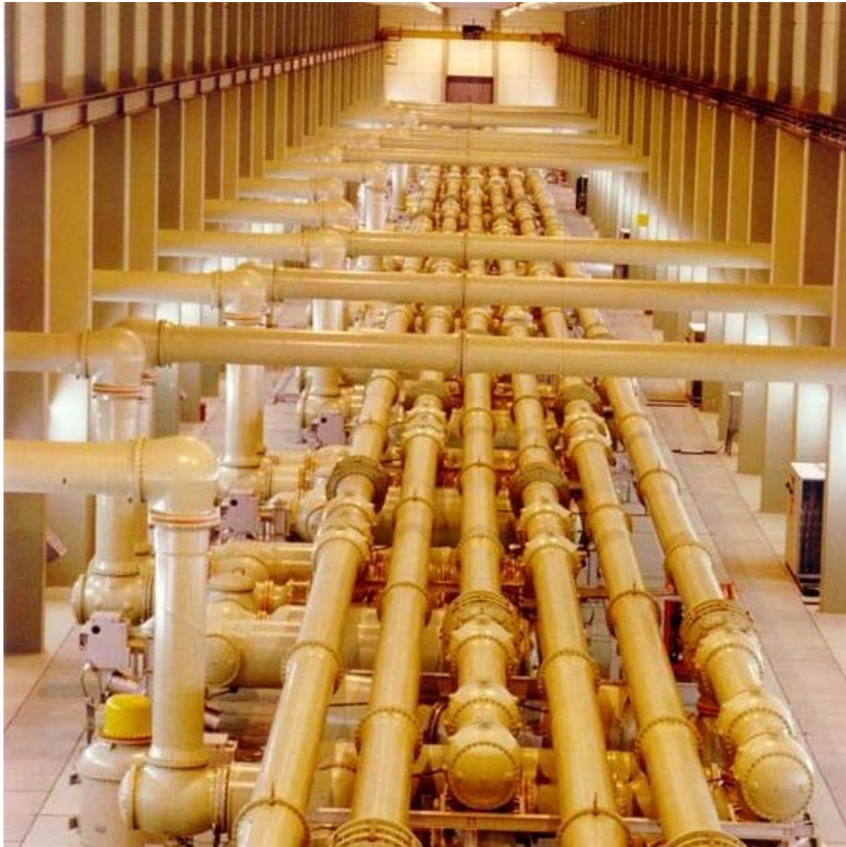
800 kV SF 6 postrojenje ABB u Južnoj Africi
